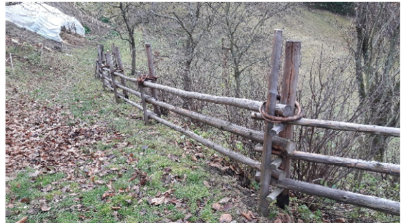
Bild 4: Stangenzaun mit Holznägeln und Weideband
