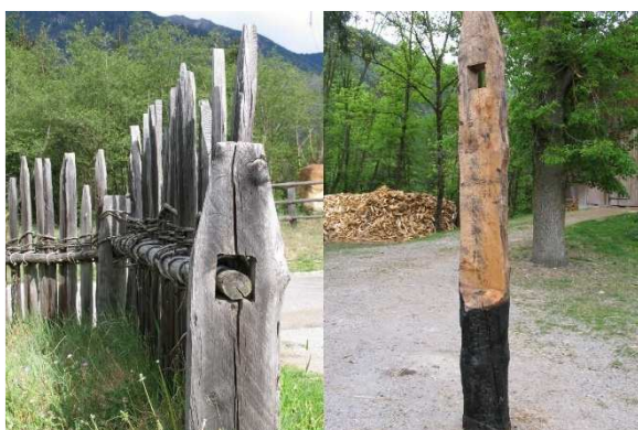
Bild 15: Speltenzaun und gelochte, angebrannte Säule
